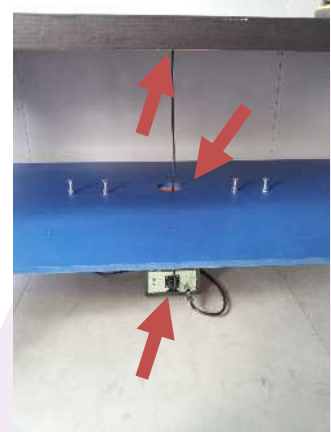
Figuur 1: Aansluiten voedingskabel op LISN
