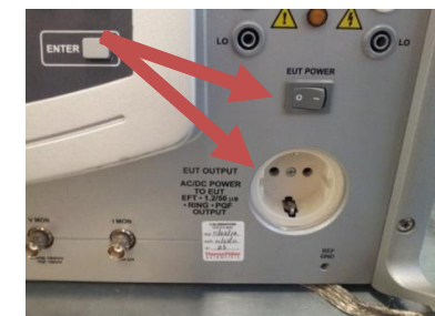
Figuur 3: Aan/uit schakelaar voor EUT spanning aan de rechterkant van de surge generator.
